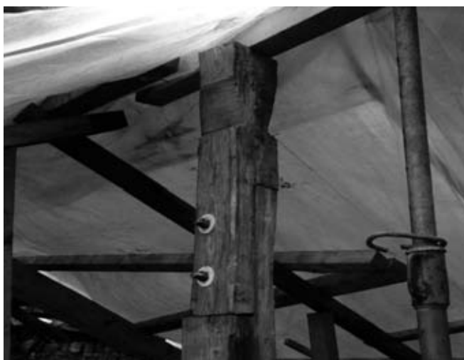
Figura 5. Intervento per la sostituzione dell'estremità deteriorata del monaco.
