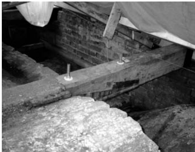
Figura 2. Intervento per la sostituzione dell'estremità deteriorata di una catena di capriata.
