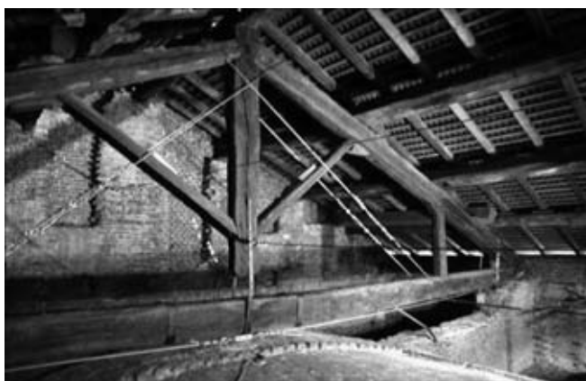
Figura 5. Ex Chiesa di S. Carpofo, Milano: consolidamento degli appoggi e delle capriate mediante cavi esterni post tesati, con inserimento di un nuovo puntello ligneo di contrasto della falda.
