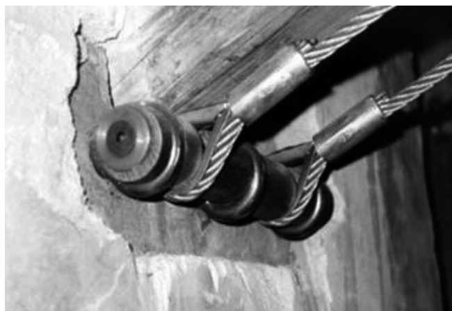
Figure 2b, 2c. Casa Ex Masciadri, Arcene, Bergamo: dettagli del consolidamento con utilizzo di un cavo sagomato post-tesato, in posizione intradosale, per consolidare i puntoni a sbalzo, fortemente inflessi.
