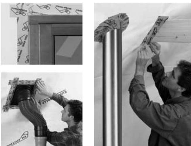
Figura 14. Accorgimenti per una buona tenuta all'aria..
