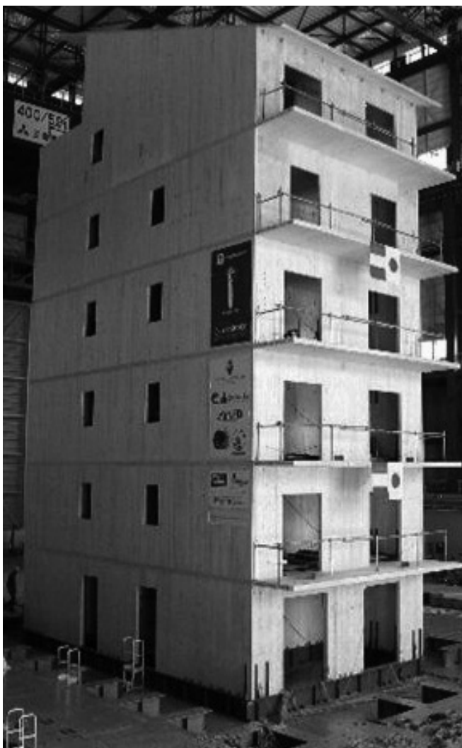
Figura 8. L'edificio SOFIE in pannelli X-LAM, di 7 piani dopo tutti i test sismici.
