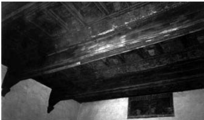
Figura 7. Solaio in legno del salone d'onore dell'Antico Palazzo Comunale di Saluzzo.
