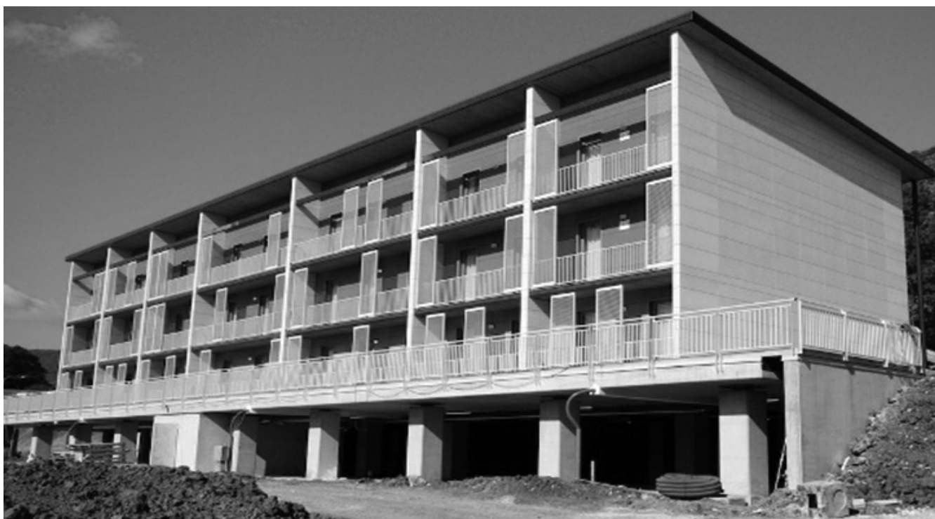
Figura 2. Edifici residenziali a L'Aquila, realizzati in 72 giorni di cantiere su nostro progetto strutturale (foto www.sistem.it ).
