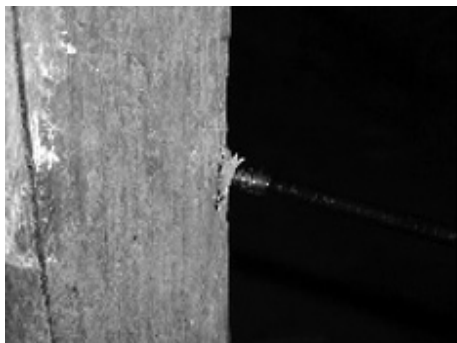
Figura 1a. Campionamento di travi in opera.
