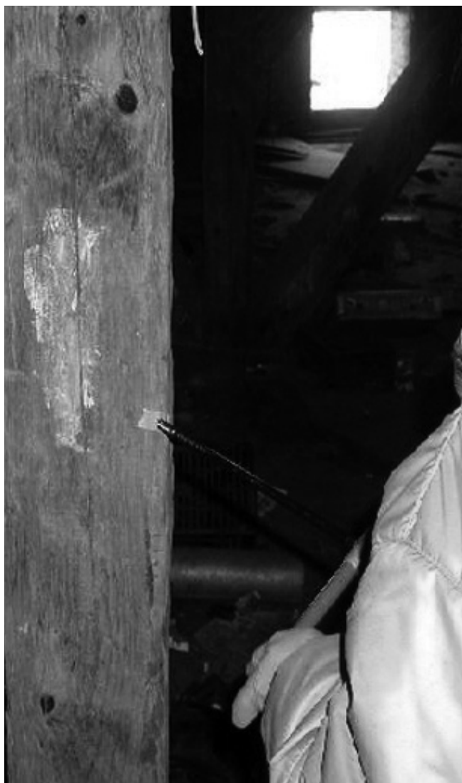
Figura 1b. Campionamento di travi in opera.
