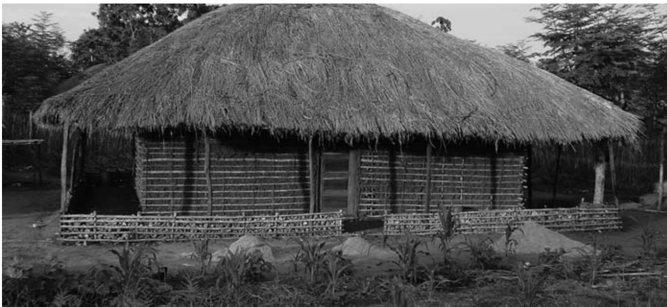
Figura 2. Abitazione tradizionale in bambù e terra in Mozambico.
