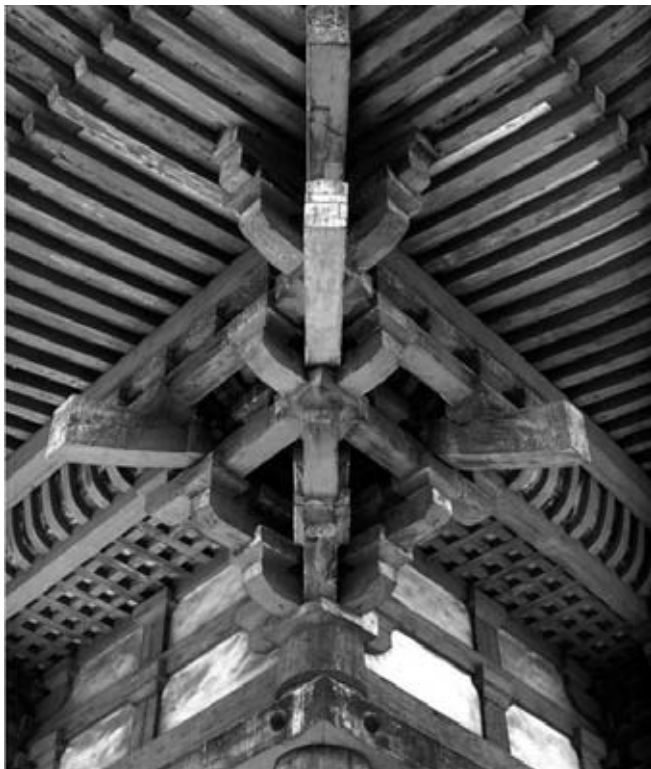
Figura 4. La capacità di assorbire energia da parte delle unioni del legno è notevole.
