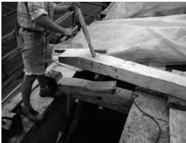
Figura 3. Posa in opera del puntone di una capriata dopo aver sostituito l'estremità deteriorata della catena.
