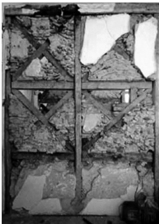
Figura 2. La parete Pombalina, Lisbona, 1755, a telaio di legno irrigidito da controventi lignei e materiale inerte.
