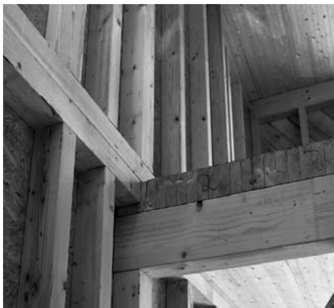
Figura 3. Solaio a tavole impilate.
