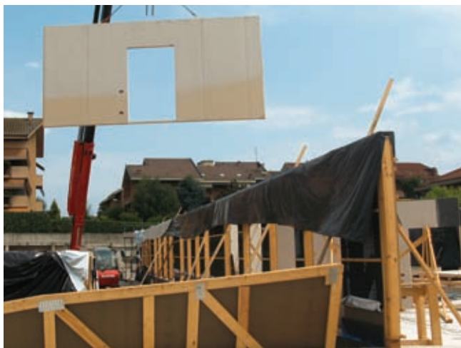
Figure 5. Il montaggio di una parete, realizzata con un sistema costruttivo a telaio formato da montanti 4.5x14,5 riempito con isolante e controventato su entrambi i lati da pannelli strutturali in legno (Durelis).
