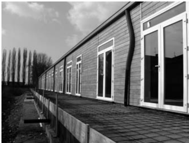
Figura 11. Il rivestimento in lamiera grecata colorata della facciata esposta a nord.
