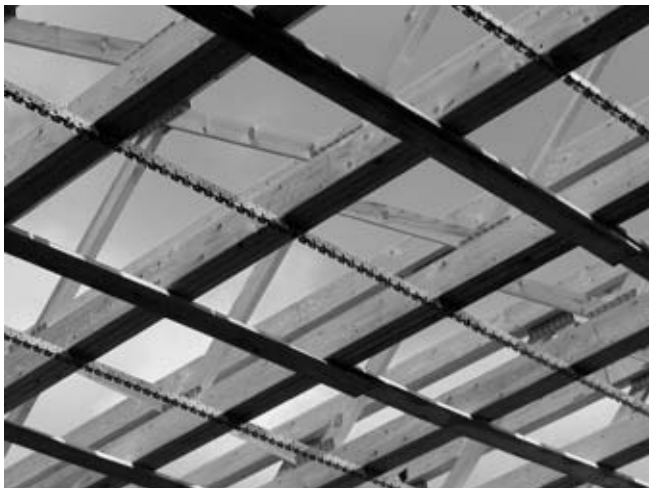
Figure 7. La copertura dei due blocchi dedicati ad aule, laboratori e dormitori prima della posa in opera dell'isolamento e delle lastre copertura e controsoffitto.
