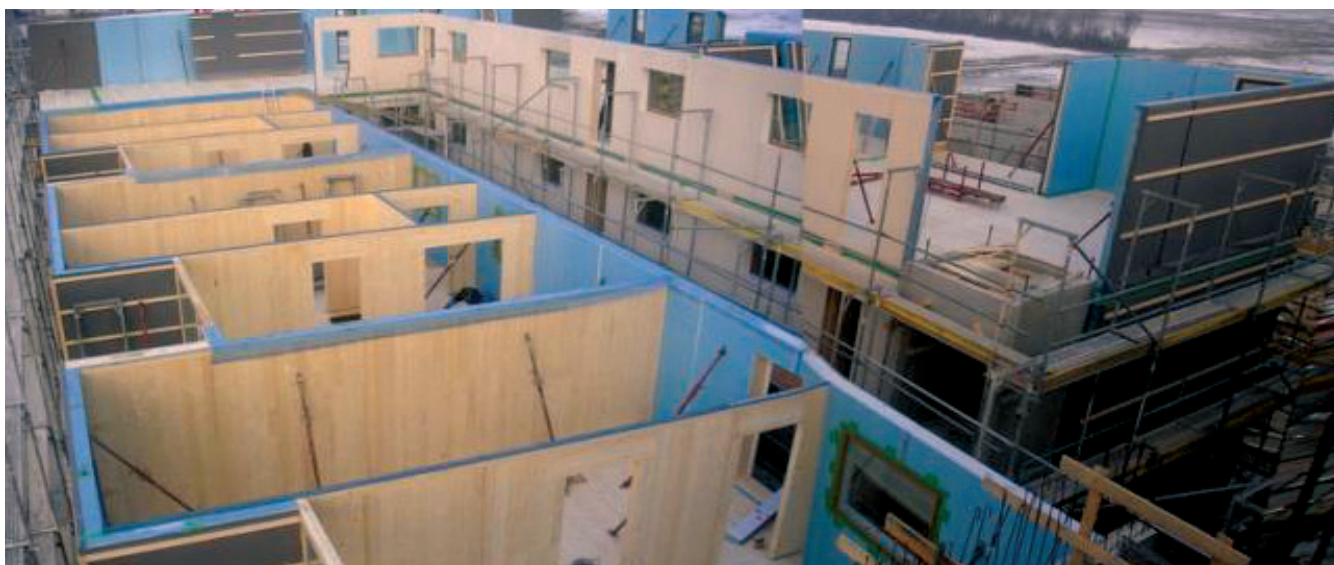
Figure 14, 15. Vienna, Complesso residenziale Muhlweg.
